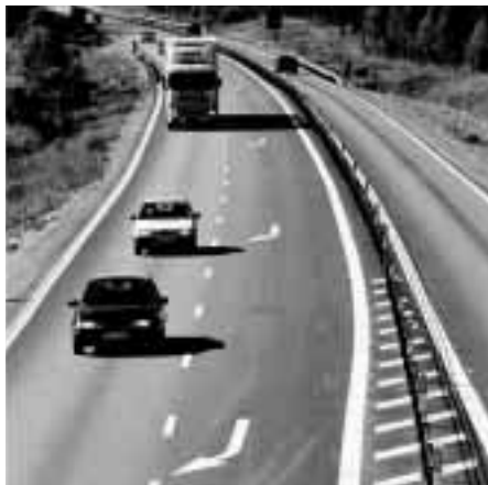
Mötesfritt. Många vägar byggs om och förses med vajerräcke till så kallad 2+1 väg.
